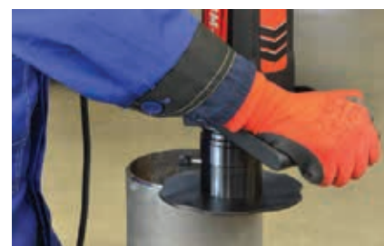
Biselado de tubería
