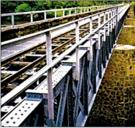
Puente de Ouémé, Benin
